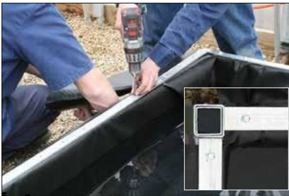
5. Продължете да прикрепяте алуминиеви ленти към рамката, докато целият периметър на облицовката на леглото не бъде закрепен.
