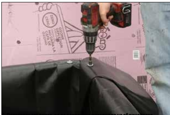
7. Повторете стъпките, за да закрепите материала на облицовката.
