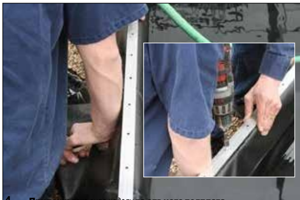
4. Приложете лека сила надолу да опънете подплата материал и фиксирана каишка с винтове Тек.
