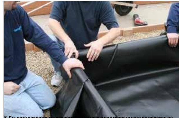
3. Сгънете подложката равномерно по ширине и над горната част на релсите на
