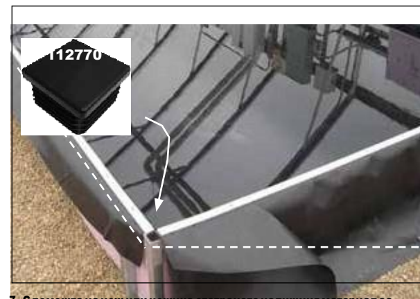
7. С помощта на нож или ножница отстранете излишния материал за подплата. Оставете 1 "или така да остане отвъд ръба на алуминиевата лента, ако желаете.
