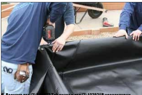
4. Вземете два (2) FA4572 Тек винта и две (2) 102921В неозакчени
