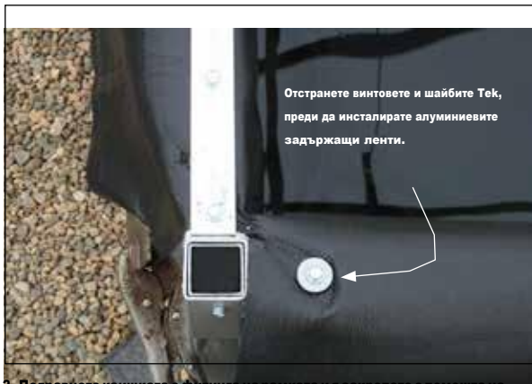
2. Подравнете каишката с фитинга на рамката и я закрепете с помощта на винта FA4572 Тек.
