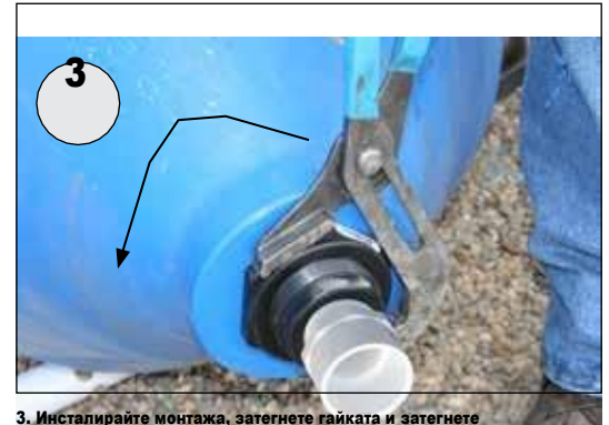
3. Инсталирайте монтажа, затегнете гайката и затегнете фитинга на адаптера.
