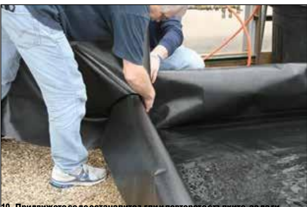
10. Придвижете се до останалите ъгли и повторете стъпките, за да ги обезопасите временно в рамка.
