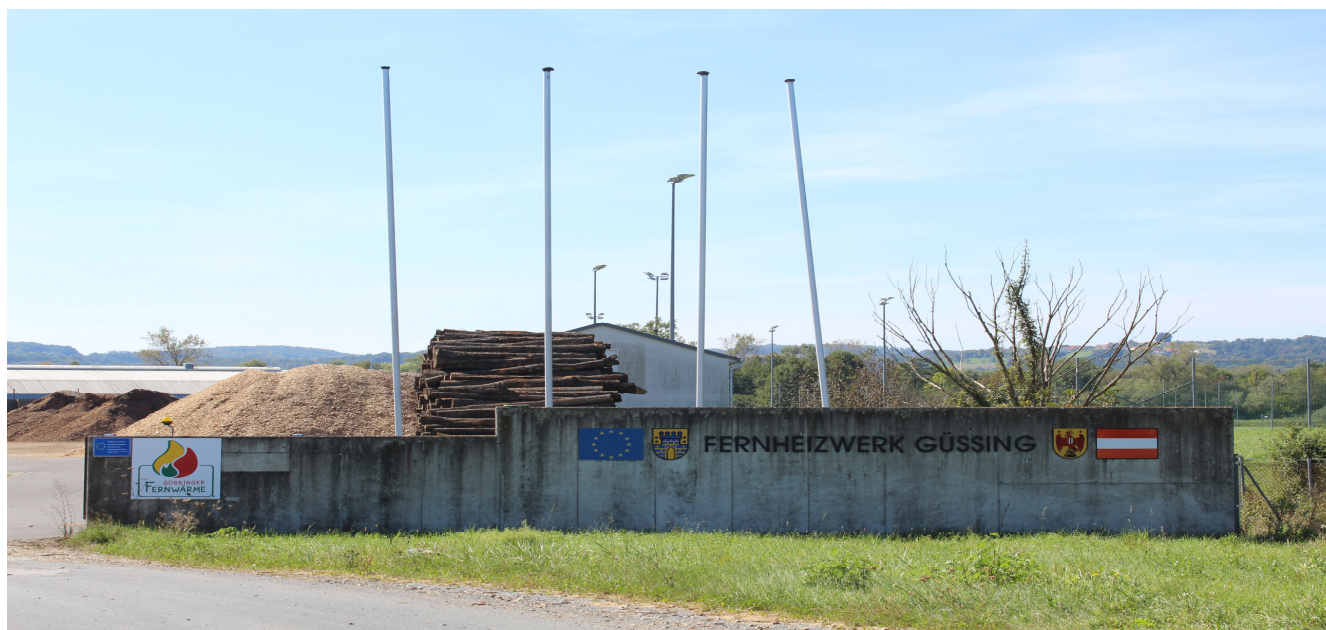
Снимка 17. НА ВХОДА НА ОБЛАСТНАТА ТОПЛОЦЕНТРАЛА НА ДЪРВЕСНИ ОТПАДЪЦИ В ГЮСИНГ С ДЪЛЖИНА НА МРЕЖАТА 37 КМ, КОЯТО ОБСЛУЖВА НАД 550 АБОНАТА
