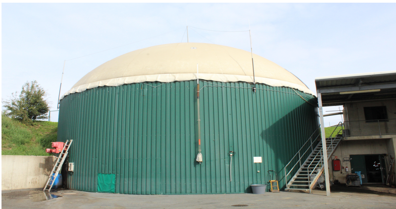
Снимки 10. БЛИЗЪК ПЛАН НА БАЛОНА ЗА ГАЗ НА ИНСТАЛАЦИЯ В STREM - ГЮСИНГ
