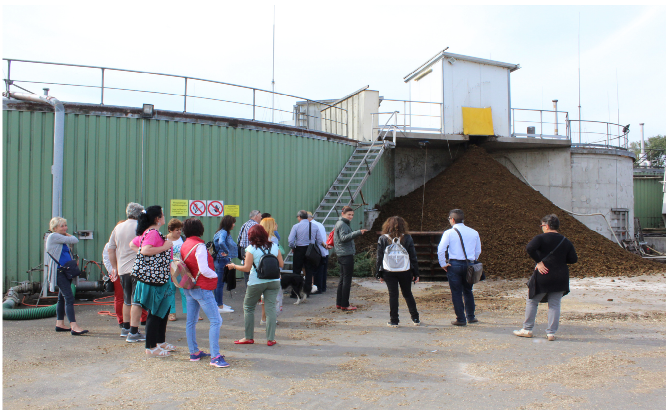
Снимки 23. ВЪНШЕН ИЗГЛЕД БИОГАЗОВА ЦЕНТРАЛА НА „WOLF NUDLES” - Гюсинг
