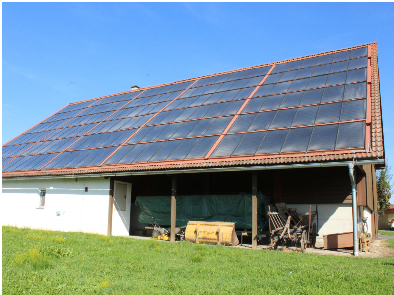
Снимка 14. ИЗГЛЕД НА СГРАДАТА НА ТОПЛОЦЕНТРАЛА НА ДЪРВЕСНИ ОТПАДЪЦИ В URBERSDORF – ОКРЪГ ГЮСИНГ, КОМБИНИРАНА С ФОТОВОЛТАИЧЕН ПОКРИВ
